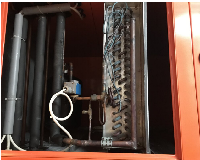
Statt mit Kältemittel betriebene Direktverdampfer (links) sind nun energiesparende und umweltschonende, weil mit wasserbetriebene, Kühlregister im Einsatz
