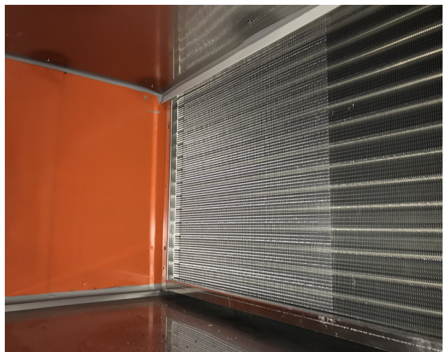
Statt mit Kältemittel betriebene Direktverdampfer (links) sind nun energiesparende und umweltschonende, weil mit wasserbetriebene, Kühlregister im Einsatz
