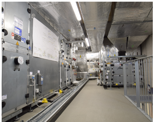
Linkes Bild: Zwei Gas-Brennwert-Heizzentralen à 65 kW zur Spitzenlastabdeckung. Rechtes Bild: Jeweils ein Lüftungsgerät ist zuständig für die Räumlichkeiten im Ober- & Untergeschoß, die Küche, die Schulungsräume, das Lager und die Nebenräume.
