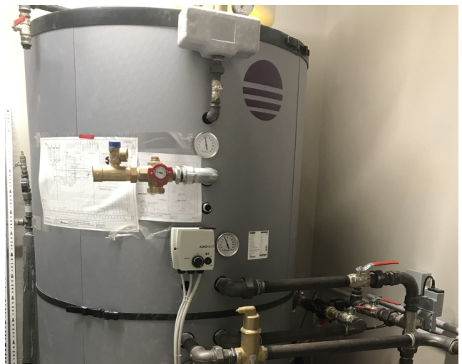
Die modulierende Luft/Wasser-Wärmepumpe MOZART für die Außenaufstellung. Der Systemspeicher EMMA mit integriertem Edelstahl-Wellrohrregister für hygienische TWW-Bereitung.
