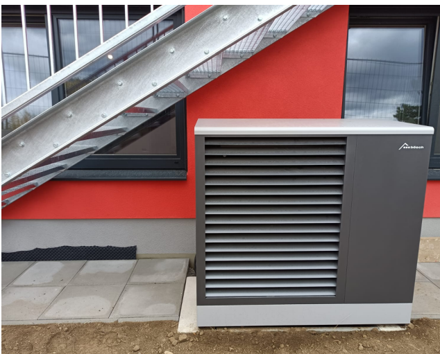
Die modulierende Luft/Wasser-Wärmepumpe MOZART für die Außenaufstellung. Der Systemspeicher EMMA mit integriertem Edelstahl-Wellrohrregister für hygienische TWW-Bereitung.
